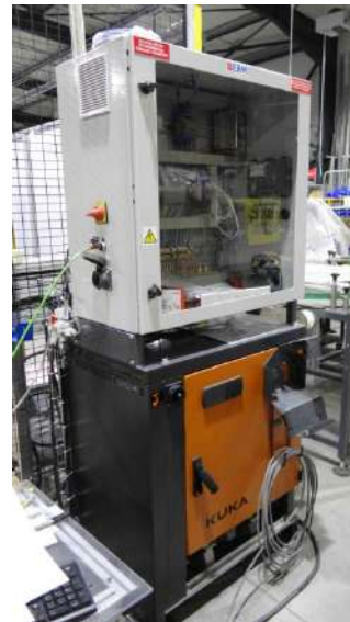
Coffret de puissance et de commande & Baie de commande du robot
