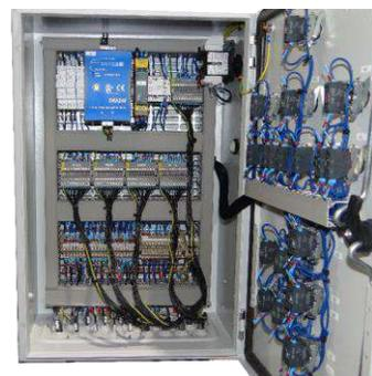
Coffret électrique avec borniers de raccordement classiques et enfichables
