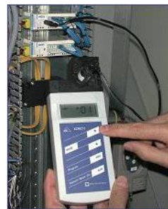
La programmation des adresses ASiBus est réalisée à l'aide d'un terminal spécifique d'adressage (Option)
