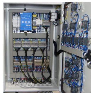
Caja eléctrica con bornes estándar enchufables
